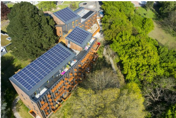
Le Grand Carcouët Bâtiment à énergie positive à Nantes 30 logements livrés en 2014 Architectes : In Situ Entreprise : Bouygues Construction
