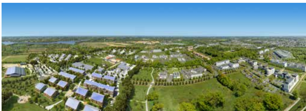
Quartier écoconçu de la Fleuriaye à Carquefou - 300 logements passifs et 6 000 m 2 de panneaux photovoltaïques. © Baloon Photo et Batimage pour LAD SELA
